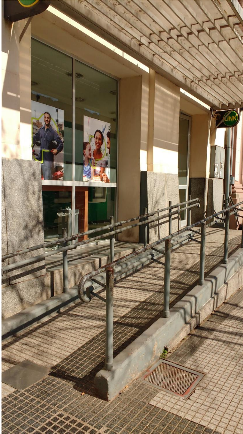
Cajero del Banco Provincia con su rampa.
