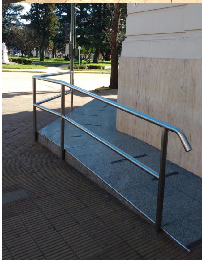
Rampa de entrada al Banco Nación
